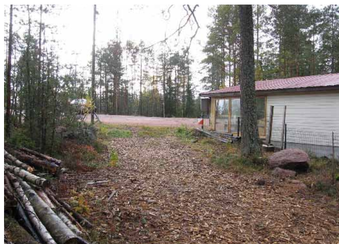
Maali. Rakennuksen kaakkoiskulma, suunta 212°
